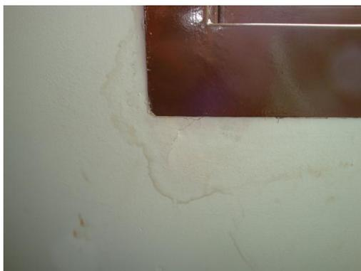
FIGURA 11 - Infiltração de água de chuva nas esquadrias.
