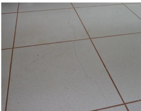
FIGURA 9 - Trincas nos pisos internos.
